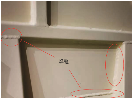
图 1 装甲钢焊接结构形式 Fig.1 Form of armor steel welding structure
