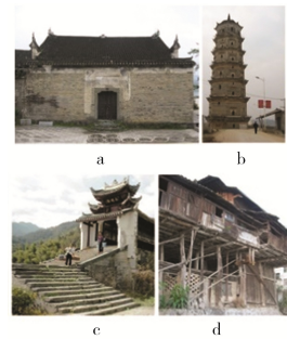
图6 梅山地区建筑文化遗产 Fig.6 The architectural heritages of Meishan region
