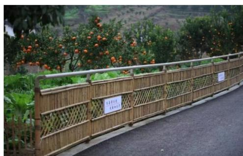
图 5 竹排造型防护围栏
